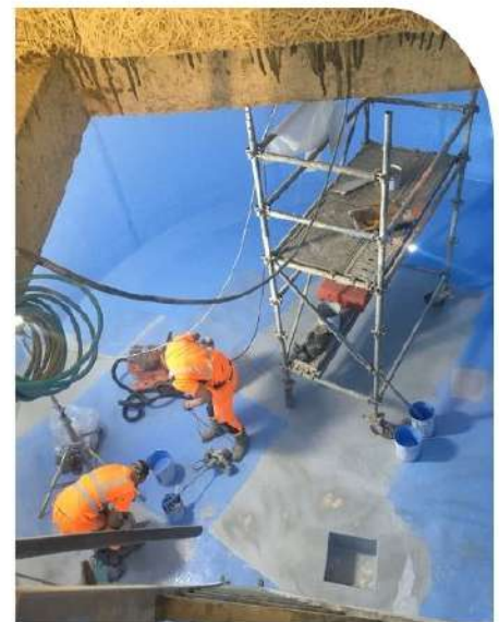
Rénovation étanchéité du réservoir de Rieutort
